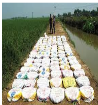
Công nghệ làm đường bằng túi đất ở nông thôn [43]
