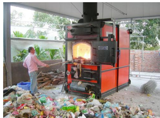
Lò đốt rác tại chỗ đối với rác thải vô cơ
