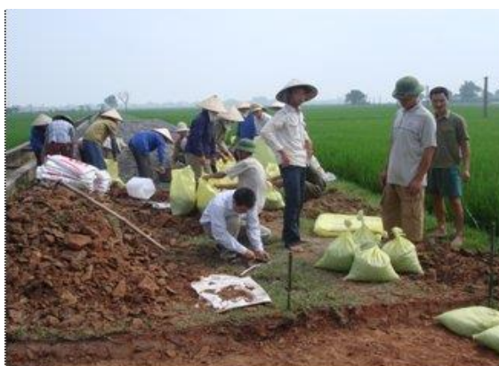
Công nghệ làm đường bằng túi đất ở nông thôn [43]
